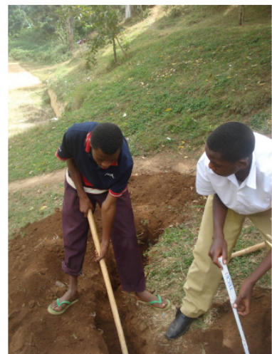
Der Graben für die neue Leitung wird ausgehoben.
