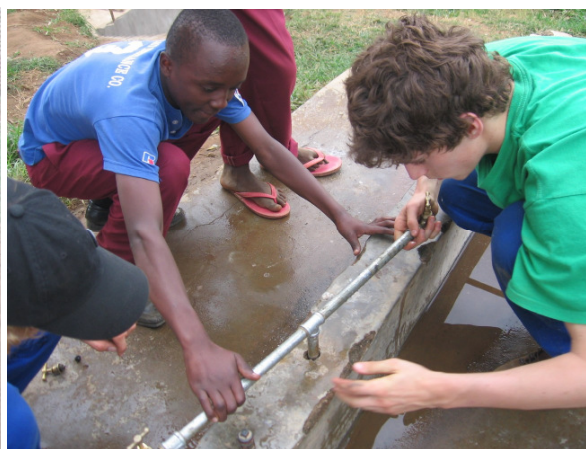
Die Zapfstellen werden installiert
