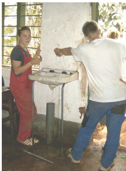
Das Waschbecken in der Cafeteria muss auf dem Tragrahmen befestigt werden.
