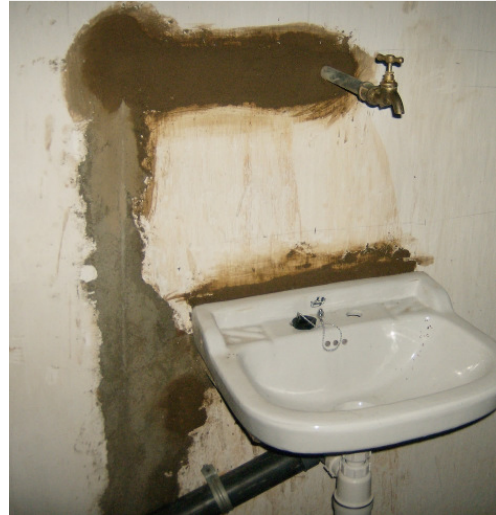
Das neue Waschbecken ist installiert. Die Wand muss allerdings neu gestrichen werden.
