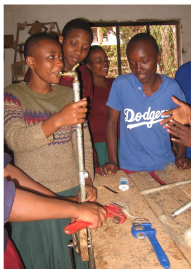
Die neue Zuleitung wird zusammengeschaubt.
