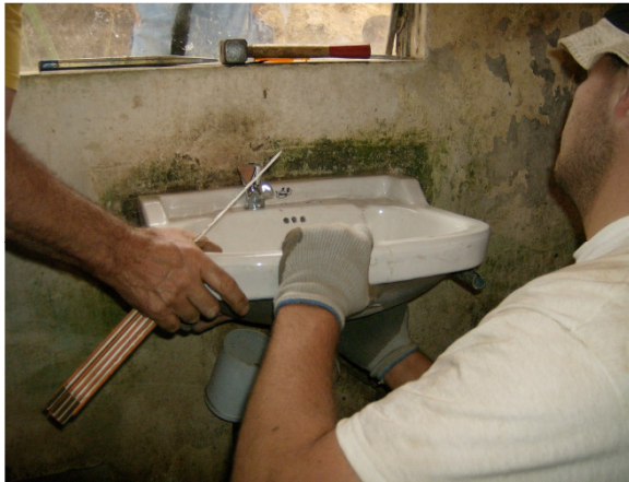
Das neue Waschbecken wird angepasst
