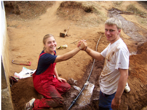
Geschafft! Die Leitung ist wieder dicht.
