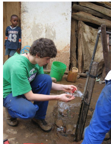
Der Schieber wird ausgetauscht.
