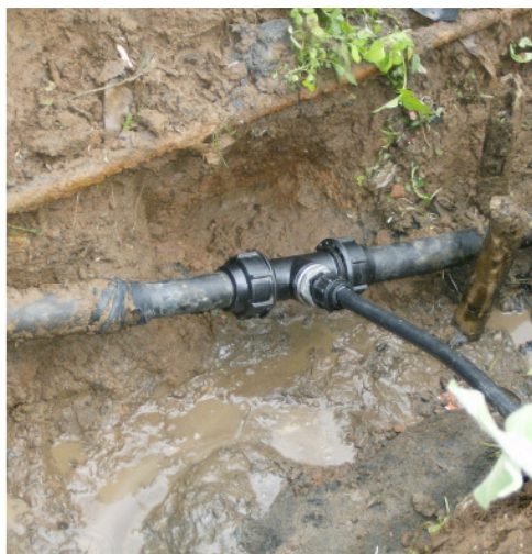
Der neue Anschluss ist fertig und dicht.
