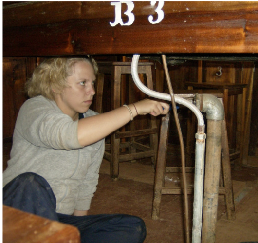
Die Ablaufgarnituren im Chemielabor werden erneuert.
