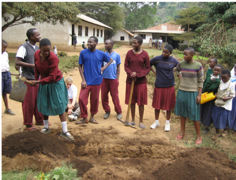
Gräben ausheben für neue Wasserleitungen
