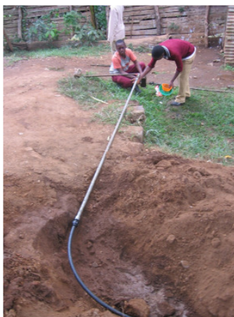
Die neue Leitung ist fertig
