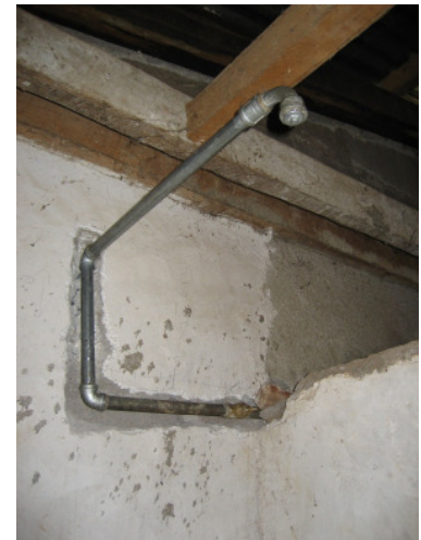
Die neue Installation ist fertig
