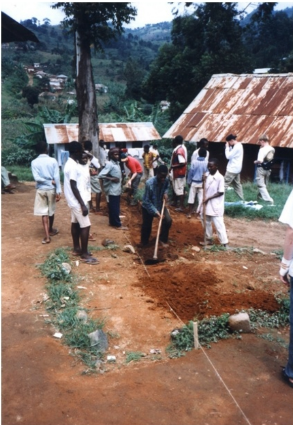
Die Wasserleitung zur Schule wird verlegt.
