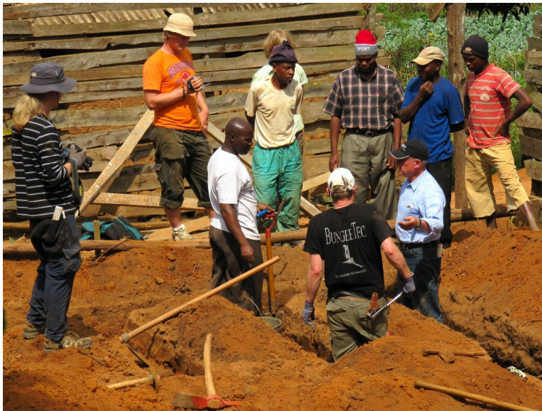
Fundamentarbeiten für den Bau der Sanitärräume
