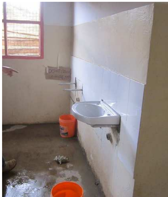
Die Halterungen für das neue Waschbecken werden in die Wand eingemauert.
