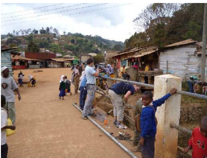
Endlich kann die Wasserleitung installiert werden.
