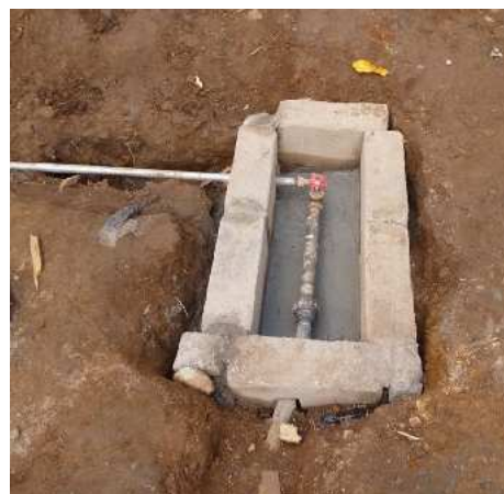
Der Schacht ist fertig.
