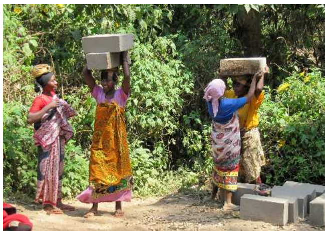
Die Frauen transportieren alle Baumaterialien.
