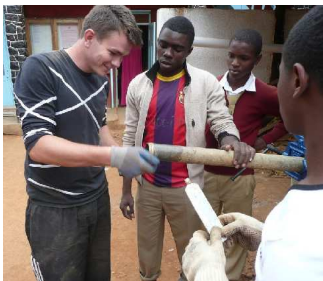
Beim Einhanfen der neuen Gewinderohre
