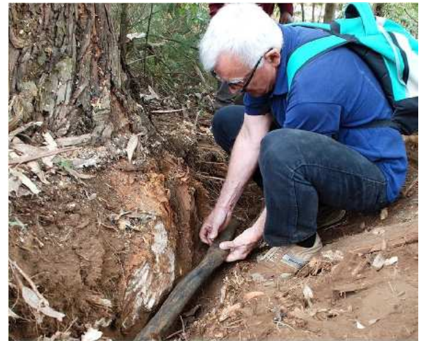
Die reparierte Leitung
