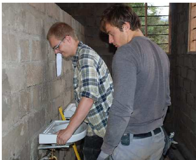
Die Aufhängung der Waschbecken wird montiert.
