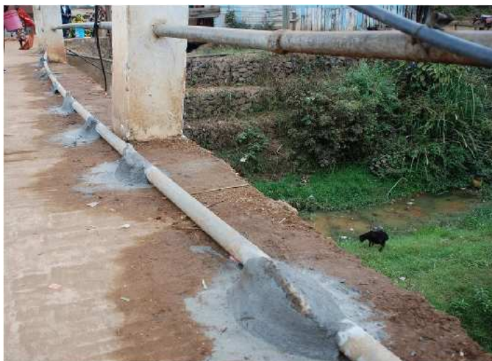
Zum Schutz gegen Autos wird die neuen Leitung eingemörtelt.
