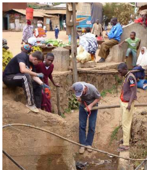
Der Anschluss der Wasserleitung wird vorbereitet
