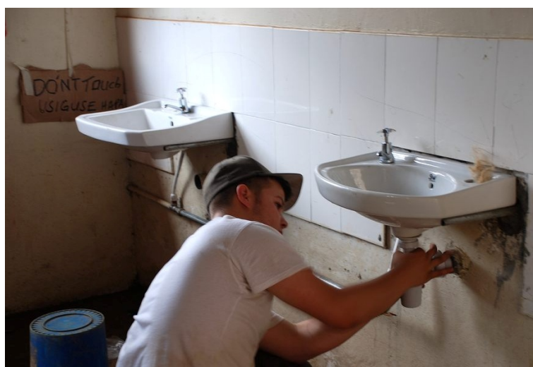
Entwendete Waschbecken werden erneuert.
