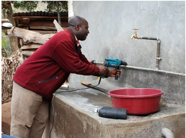
Nach einer Stunde Stromausfall können wir endlich die Bohrmaschine zum Einsatz bringen.
