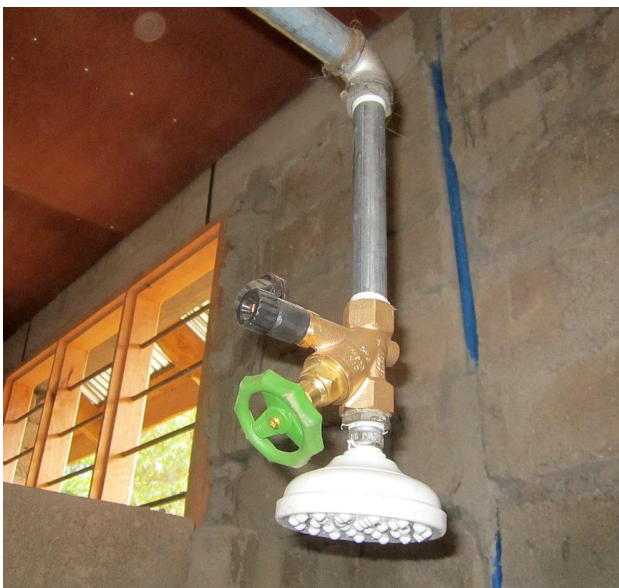
Die fertiggestellten Duschen.
