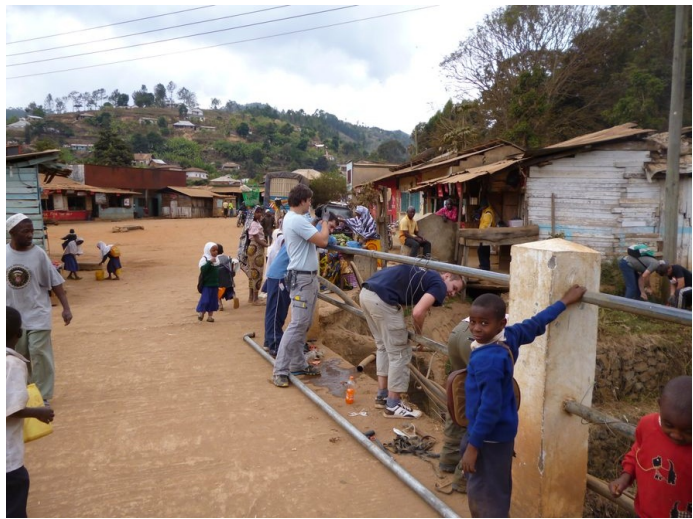
Die neue Leitung über die Brücke liegt bereit.
