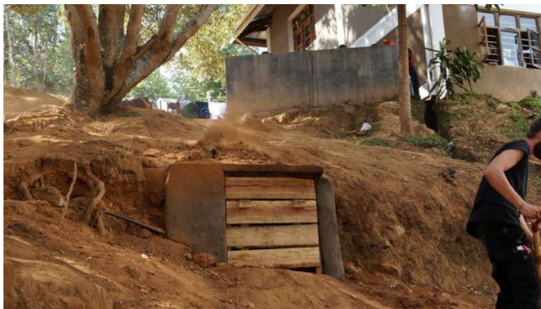
Die Trinkwasserverteilerstation ist fertiggestellt.
