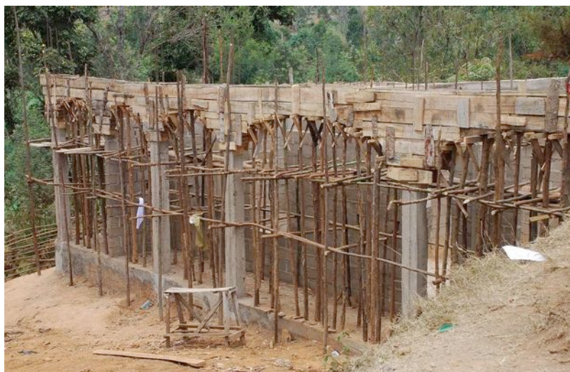
Der Rohbau der neuen Mensa
