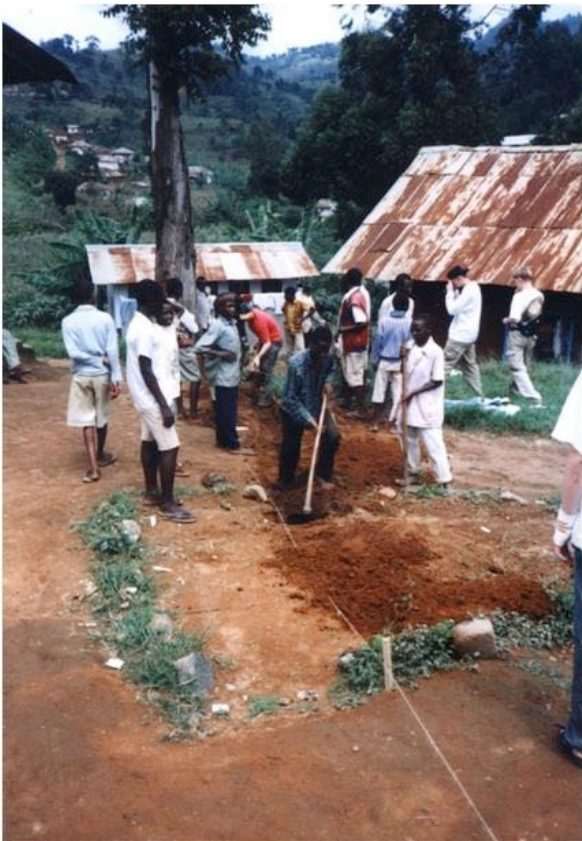
Die Wasserleitung zur Schule wird verlegt.
