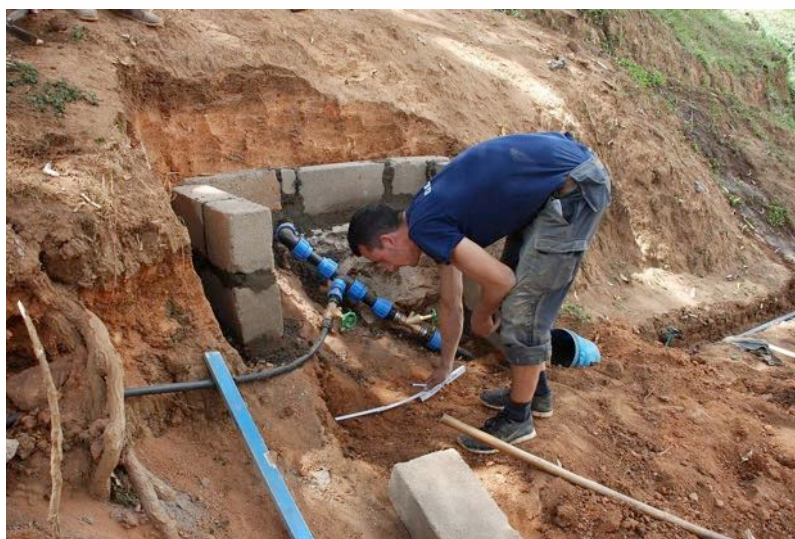
Der Trinkwasserverteiler wird ummauert.
