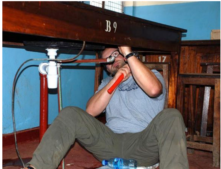
Reparatur im Chemielabor: Auch unbequeme Arbeit ist notwendig
