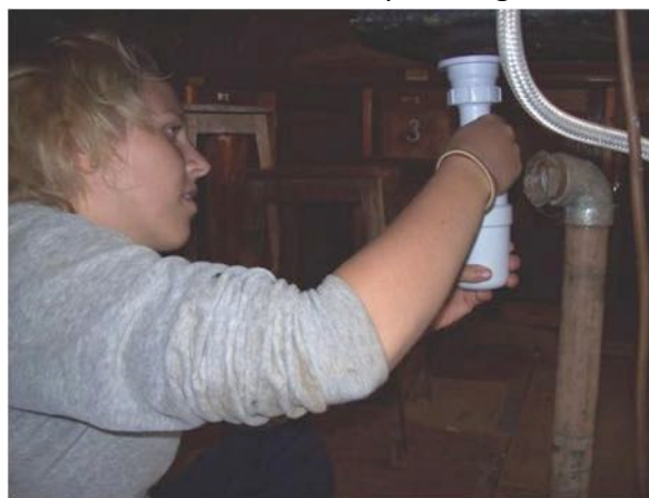
Im Chemielabor werden die Abläufe erneuert.
