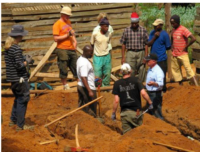
Fundamentarbeiten für den Bau der Sanitäräume
