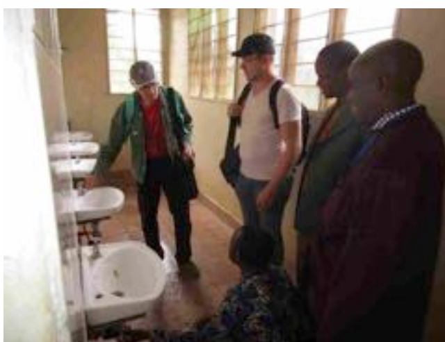
Begutachtung der Instandsetzungsarbeiten mit der Schulleitung
