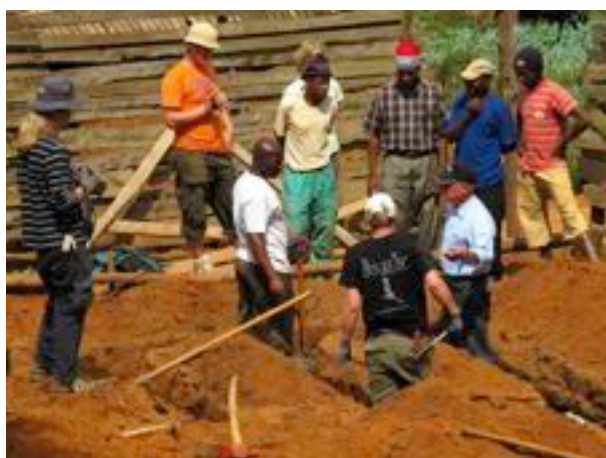
Fundamentarbeiten für den Bau der Sanitarräume
