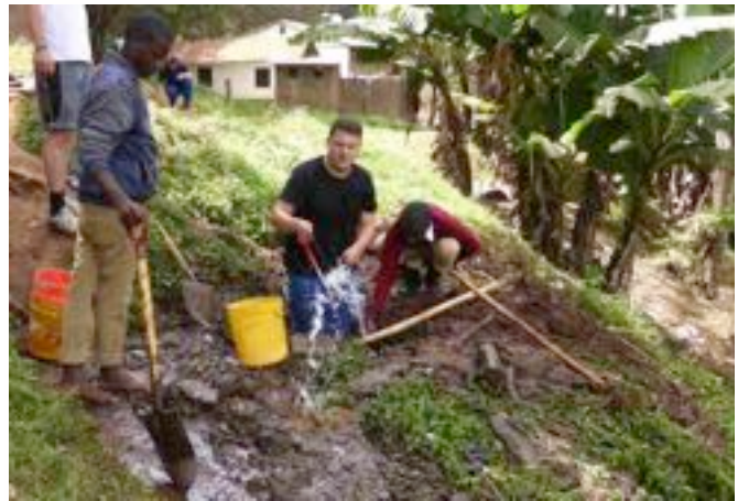
Arbeiten unter „Druck“
