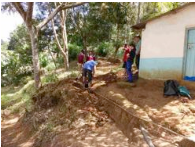
Die alte Stahlleitung wird durch Kunststoff ersetzt
