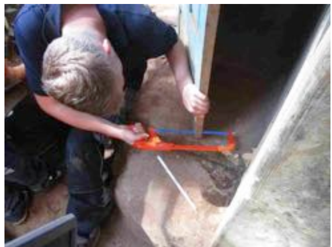
Die Tür wird an den Verlauf der Wasserleitung angepasst.
