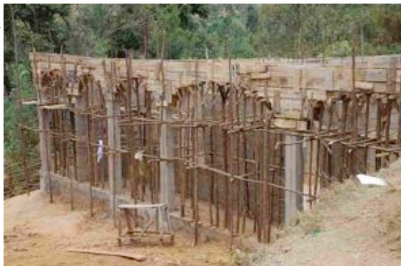
Der Rohbau der neuen Mensa
