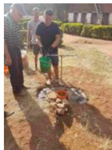
Die neue Wasserstelle für die Lwandai Primary School ist fertig
