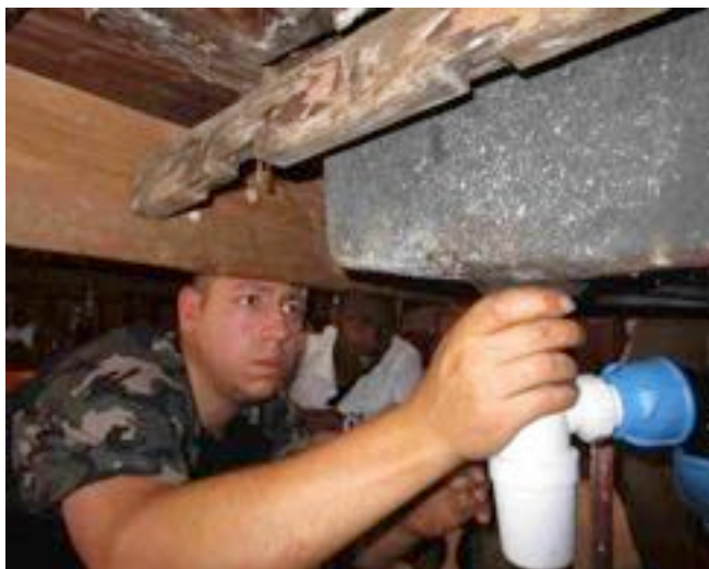
Ein neuer Geruchverschluss wird mit Silikon abgedichtet
