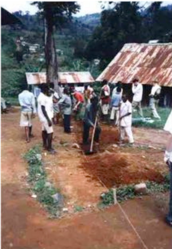
Die Wasserleitung zur Schule wird verlegt.
