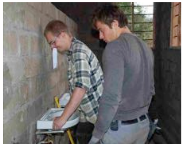
Die Aufhängung der Waschbecken wird montiert.
