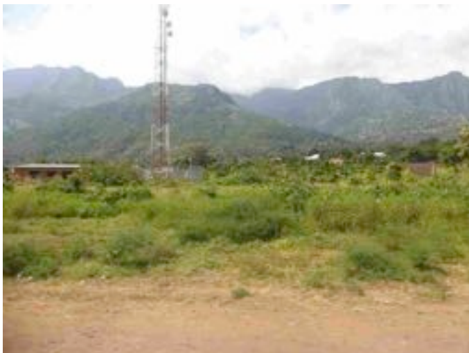
Mobilfunkturn in der Massai-steppe
