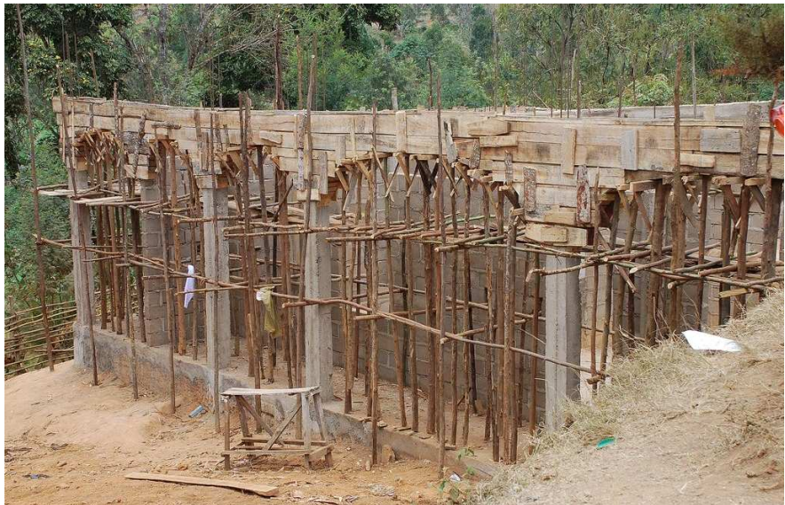
Der Rohbau der neuen Mensa
