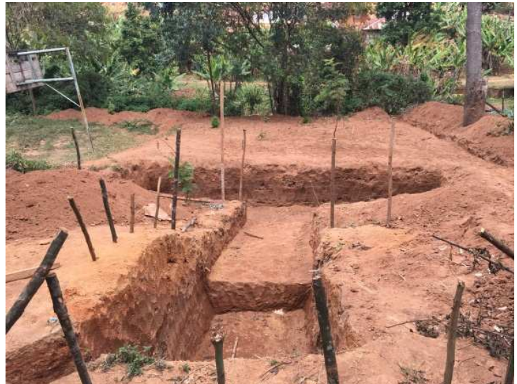
Blick auf die Grube für die Klärtanks
