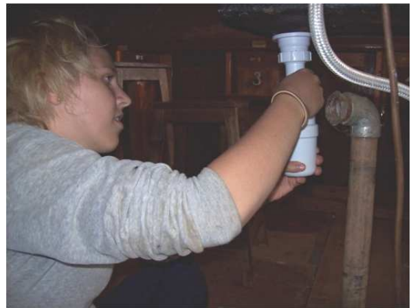
Im Chemielabor werden die Abläufe erneuert.
