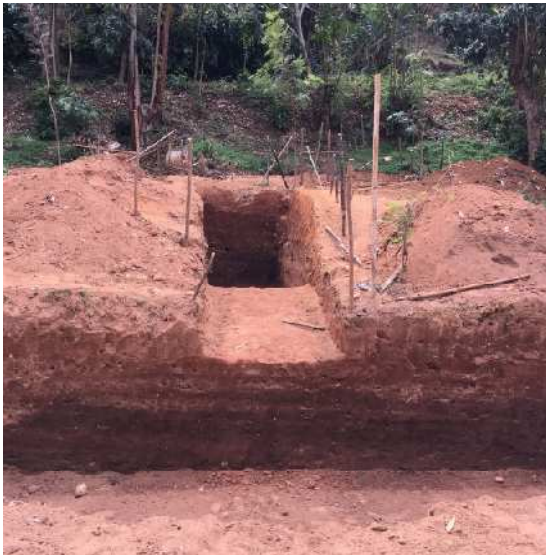
Blick auf die Grube für den Vorfluter / Heber
