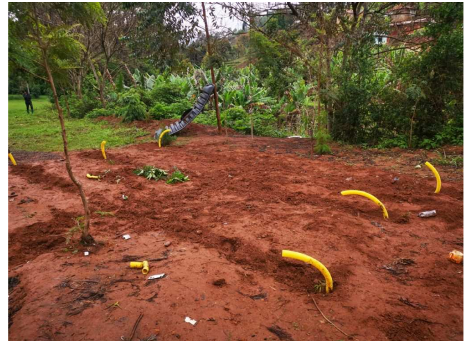
Die Bewässerungsrohre sind im Feld verlegt.
