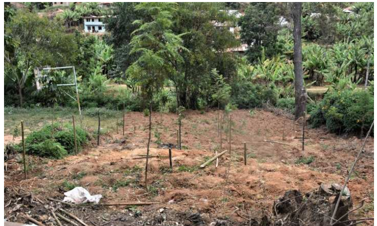
Das Schnurgerüst ist fertig.
