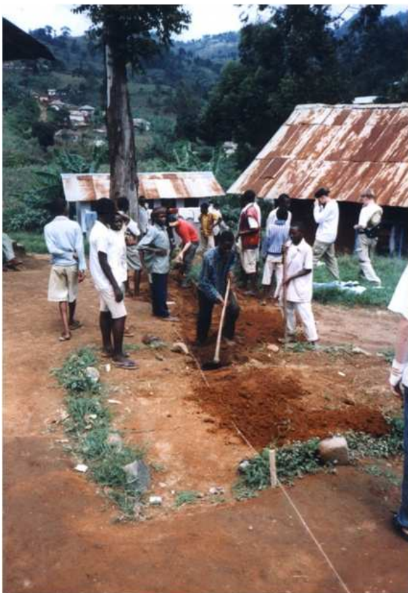
Die Wasserleitung zur Schule wird verlegt.
