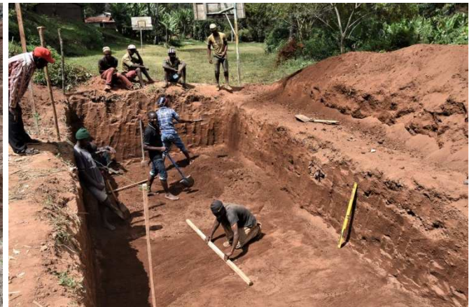
Die Gruben für die biologischen Klärtanks sind fertig.
