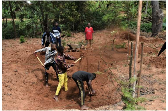
Lokale Hilfskräfte beginnen mit den Aushubarbeiten
