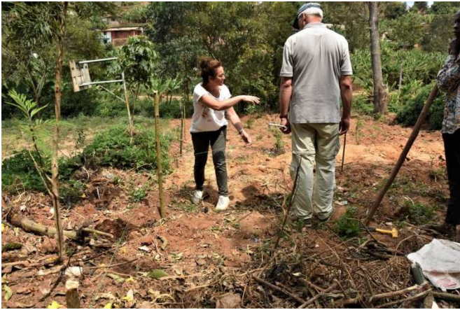
Das Gelände für die Kläranlage wird abgesteckt
