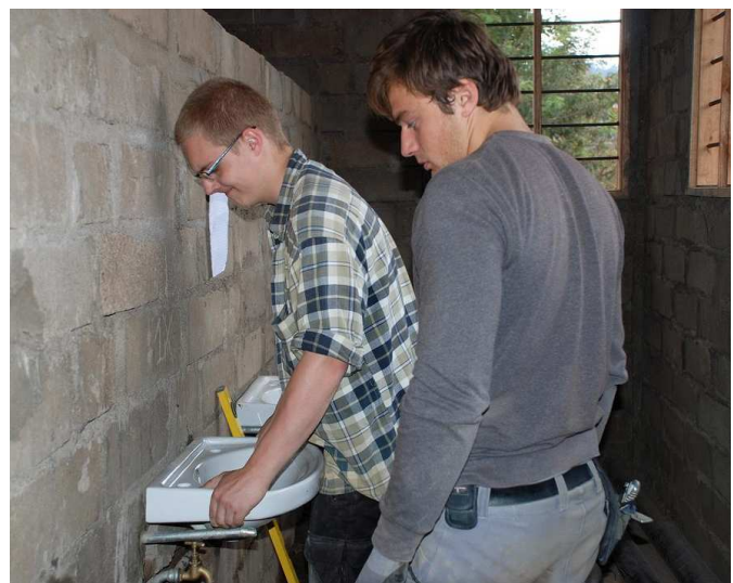
Die Aufhängung der Waschbecken wird montiert.
