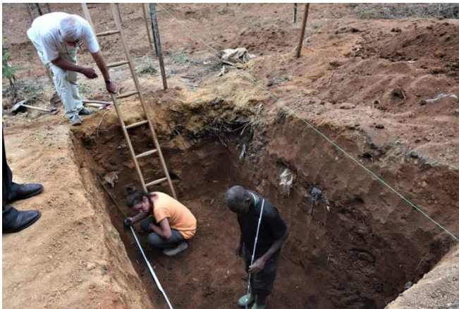
Die Grube für den Vorfluter/Heber ist fertig.
