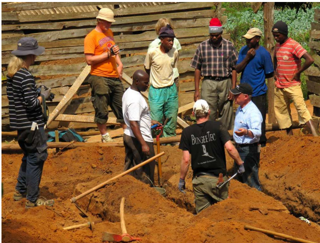
Fundamentarbeiten für den Bau der Sanitärräume
