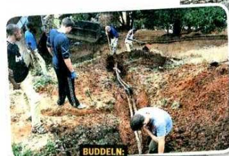
BUDELN: Die Berufsschüler aus Hannover reparieren eine Trinkwasserleitung.
