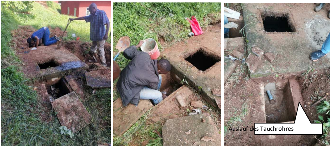
Die 3-Kammerklärgrube wird entleert und ein Ablauf mit Tauchrohr eingemauert.
