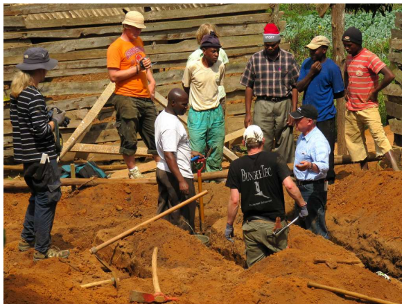
Fundamentarbeiten für den Bau der Sanitärräume
