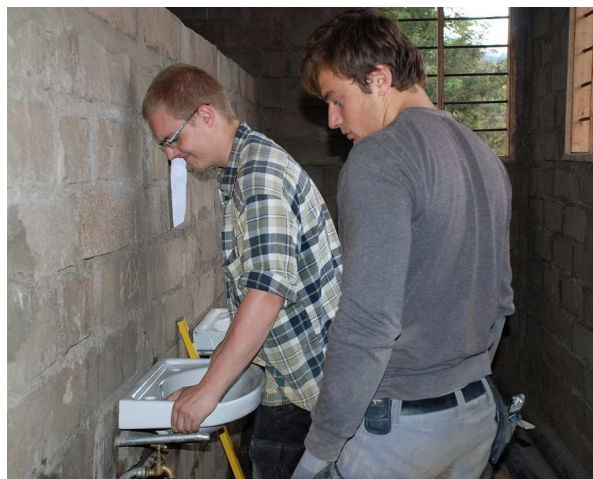
Die Aufhängung der Waschbecken wird montiert.
