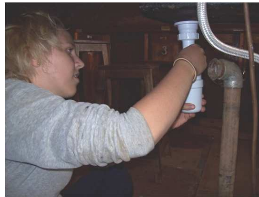
Im Chemielabor werden die Abläufe erneuert.
