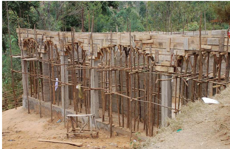
Der Rohbau der neuen Mensa
