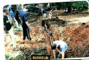
BUDDELN: Die Berufsschüler aus Hannover reparieren eine Trinkwasserleitung.
