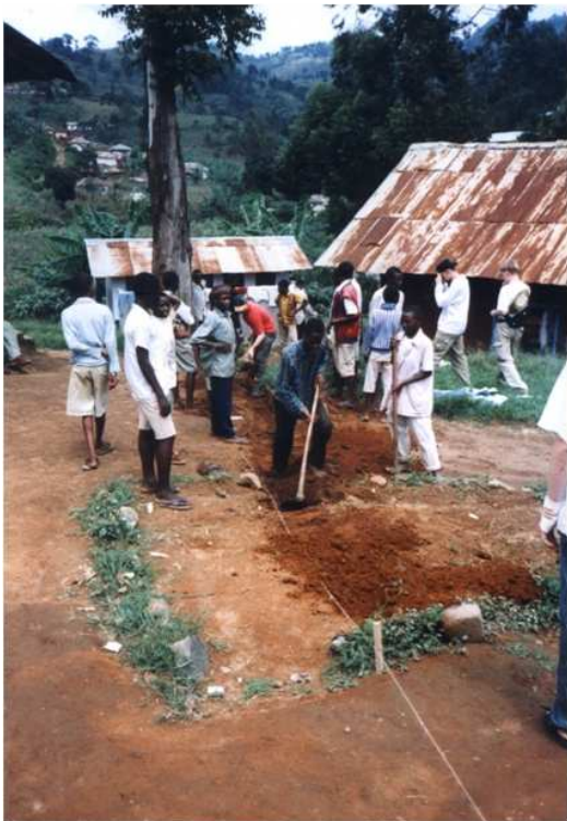
Die Wasserleitung zur Schule wird verlegt.
